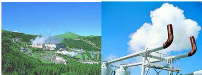
Slika 9: Hačobaru geotermalna elektrana u Oita prefekturi (levo) i para koja dolazi iz bušotine 3.000 metara dubokog geotermalnog rezervoara (desno)
