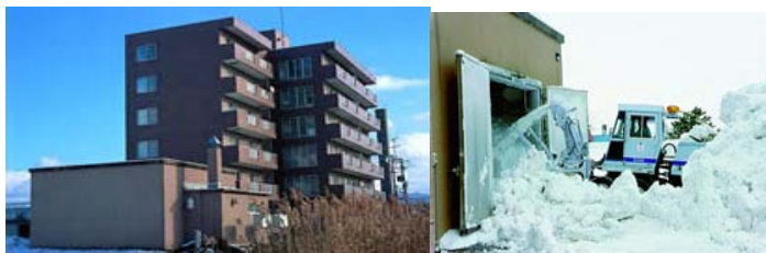
Slika 7: Zgrada u mestu Bibai na Hokaidu koja koristi zimski sneg za hlađenje leti (levo) i obližnje skladište za 105 tona snega (desno)
