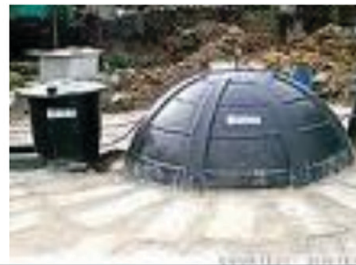
Подземен дигестор со импрегнирана церада за собирање на гасот и со заштитна пластична купола
